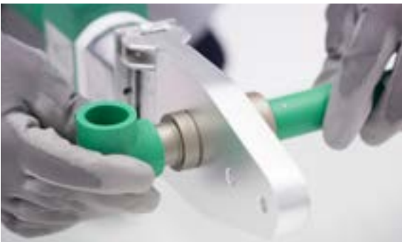
Aplicar las matrices en tubo y accesorio
