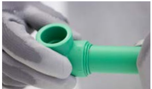
Introducir el tubo en el accesorio
