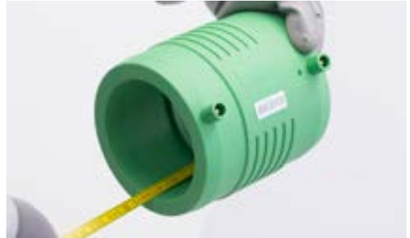
Comprobar la longitud de tubo a introducir en el accesorio
