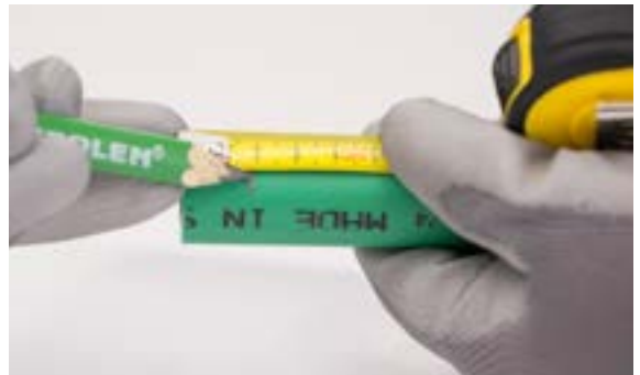
Marcar en el tubo la longitud medida
