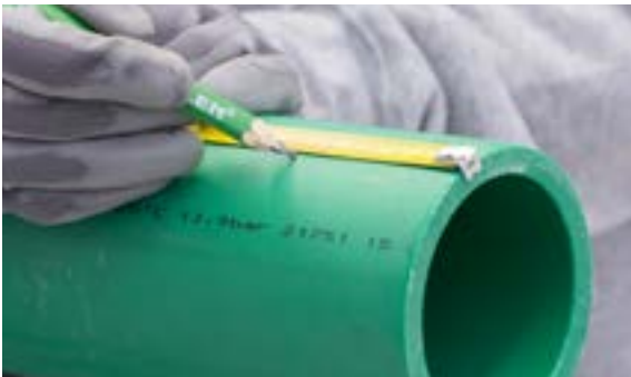
Marcar en el tubo la longitud medida
