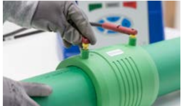
Conectar los bornes de la máquina al accesorio
