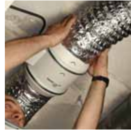
Acoplar los conductos.
