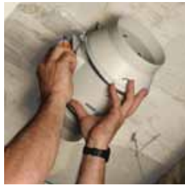
Colocar el cuerpo motor.
